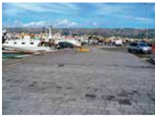
Nuova pavimentazione molo di levante
