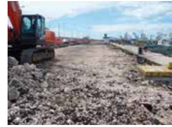
Lavori in corso molo di levante
