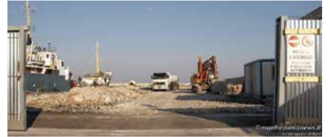
Lavori in corso sul molo di ponente di Manfredonia
